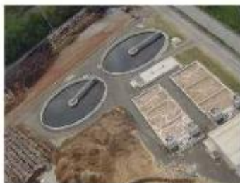
Biološka čistilna naprava papirnice
